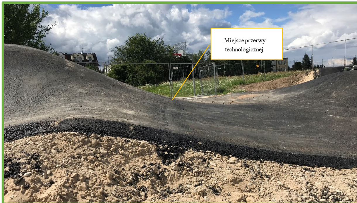
Ryc. 3 Prawidłowo wykonane połączenia – bez wyczuwalnych uskoków ani zmian profilu przeszkody.
