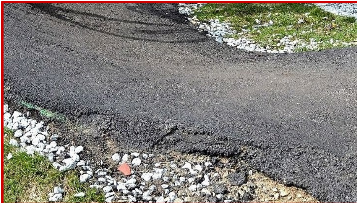
Ryc. 1 Nieprawidłowe wykończenie krawędzi nawierzchni jezdnej – nierówne, bez fazowania, z ubytkami.
