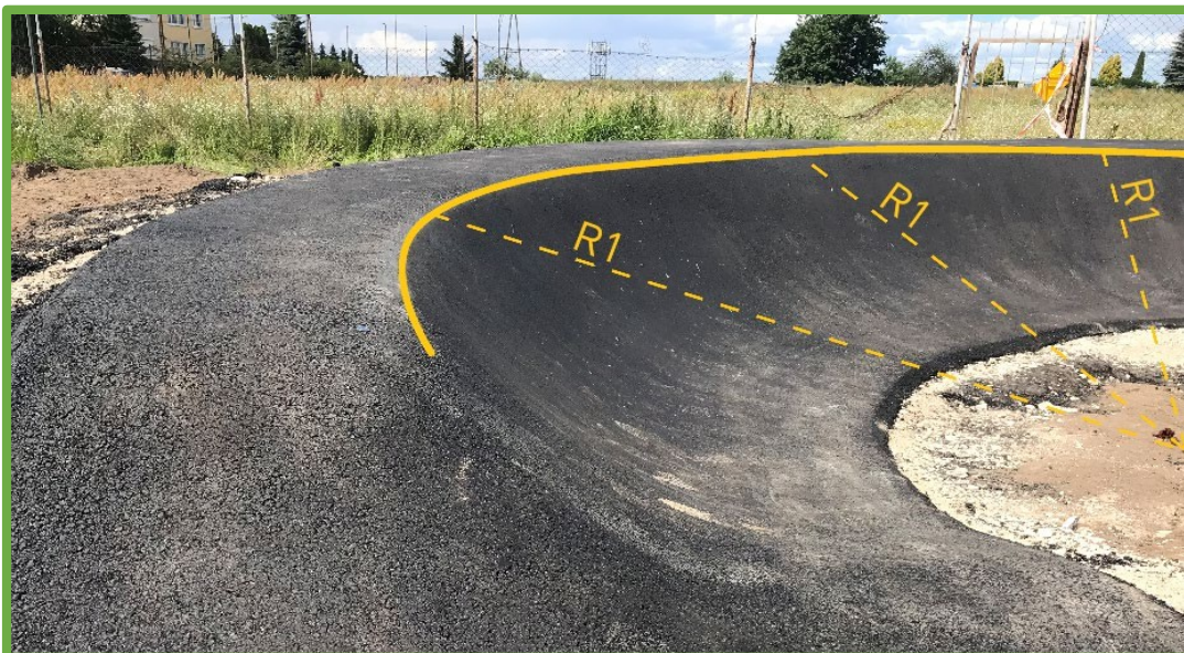
Ryc. 7 Prawidłowo wykonany zakręt profilowany – o jednostajnym promieniu zakrętu
