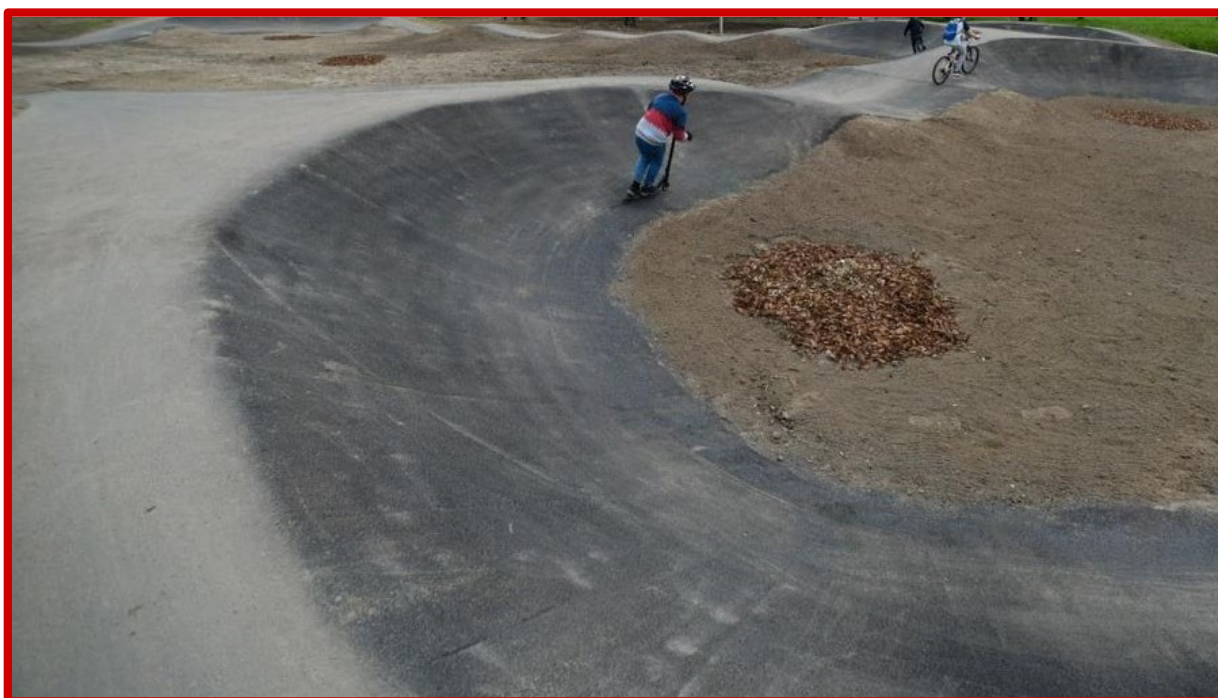
Ryc.5 Prawidłowo wykonany zakręt profilowany, którego przekrój stanowi wycinek koła.
