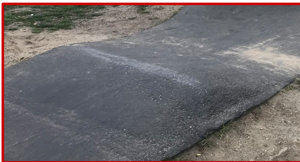
Ryc. 8 Niepoprawnie wykonany garb – o licznych nierównościach i złym kształcie
